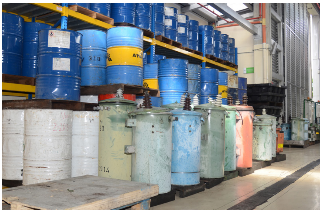
◀ Residuos peligrosos generados en actividades de mantenimiento de equipos con aceites dieléctricos
